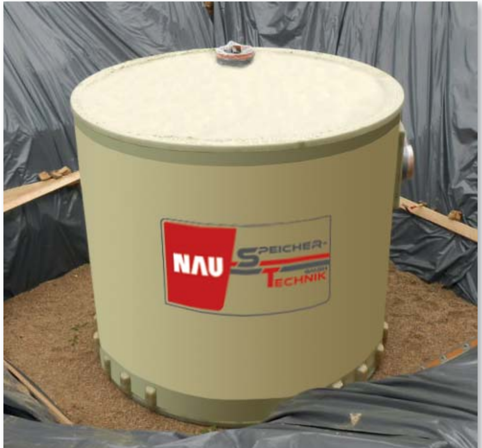
Der NAU-Wärmespeicher PUB-GEO zur unterirdischen Lagerung thermischer Energie. Im unteren Bereich ist die Verzahnung für die Auftriebssicherung zu sehen, die bei hohem Grundwasserstand empfohlen wird.
